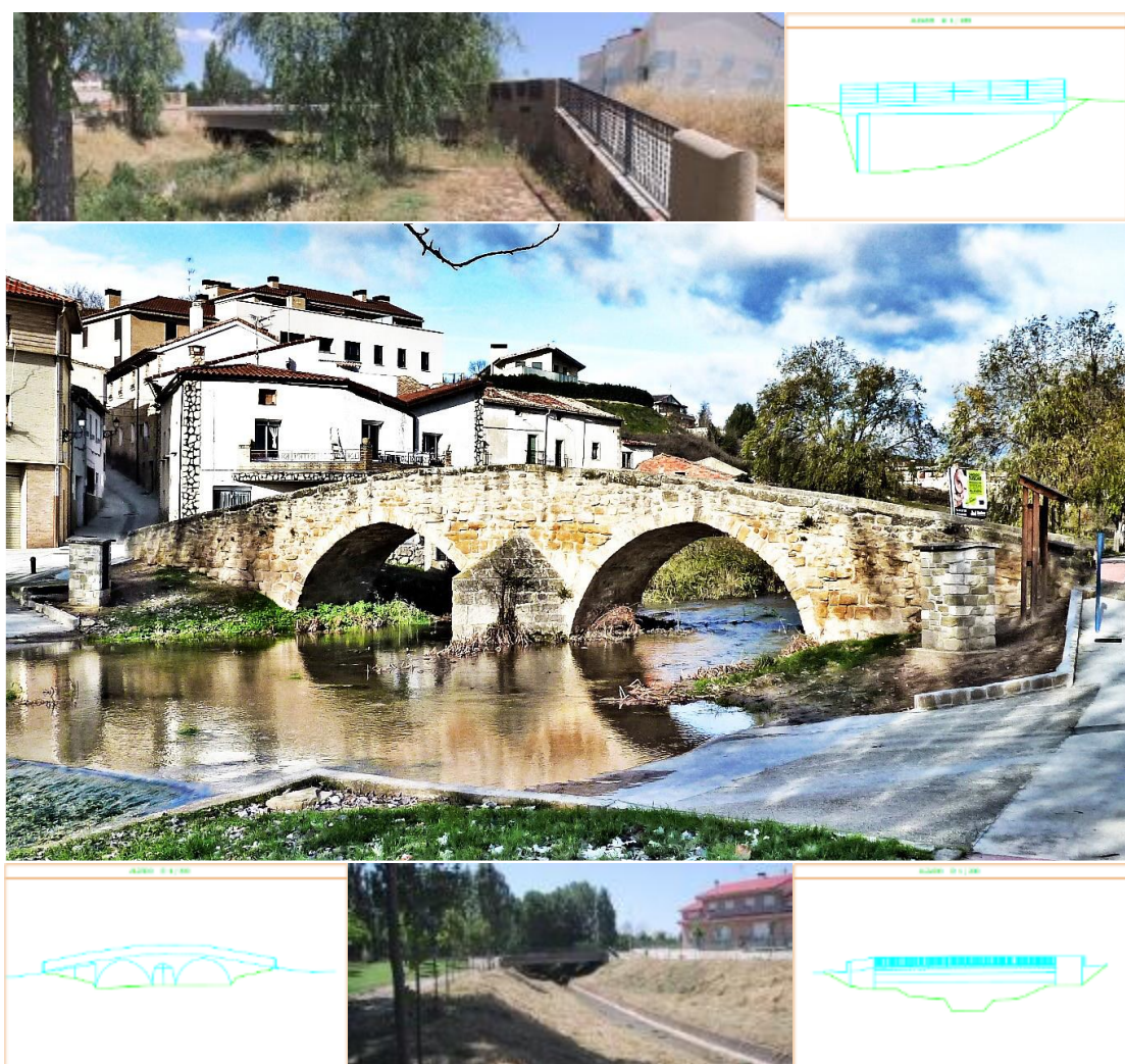
Figura 8. Fotos y alzados de la geometría precisa de las tres de las 13 obras de fábrica de presentes en el tramo del río Irantzu objeto de estudio.
